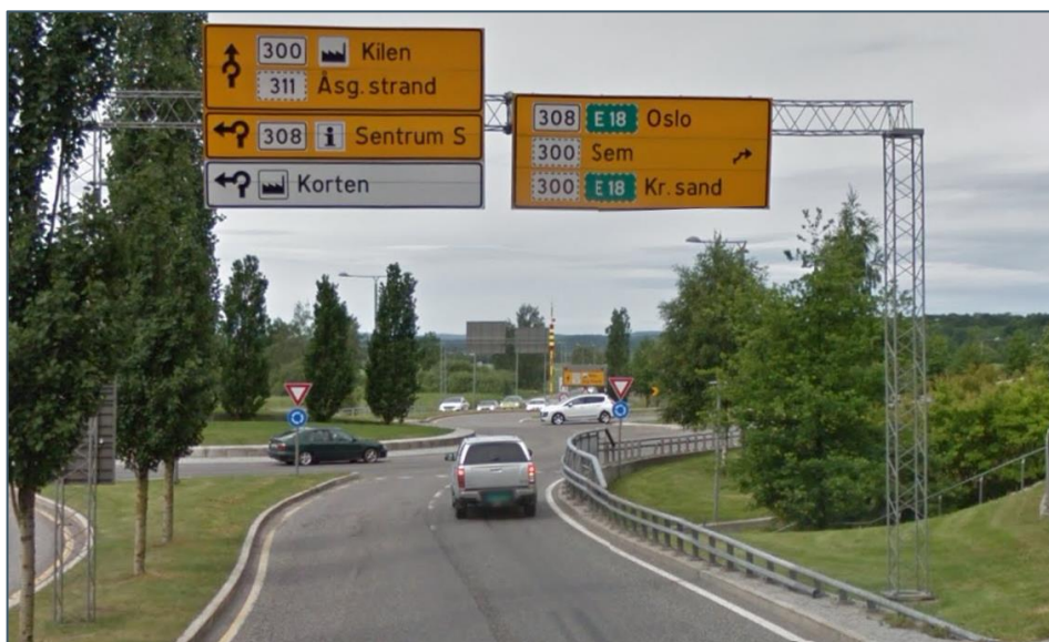
Figur 5 Skilting inn mot den søndre rundkjøringen fra Fv.468 Farmannsveien.
